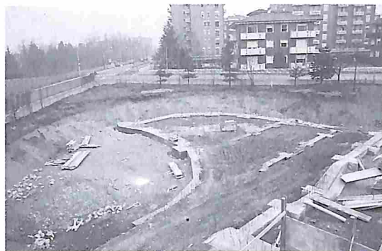
Posa delle fondamenta
