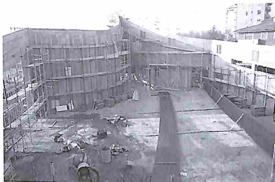
Interno con travi sottotetto da posizionare
